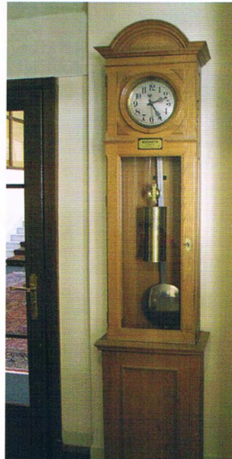
Hauptuhr im Hotel Waldhaus, Sils im Engadin. Die Uhr ist heute noch im Betrieb und steuert ungefähr 10 Nebenuhren. Geliefert zur Eröffnung 1908.
